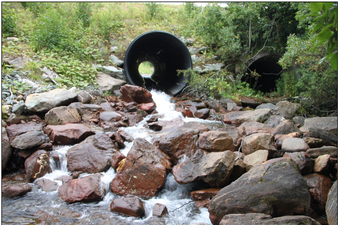
Figur 4.8. Vandringshinder Eliaselva; kulverten under eksisterende E8. Foto: Kristin Sommerseth Johansen
